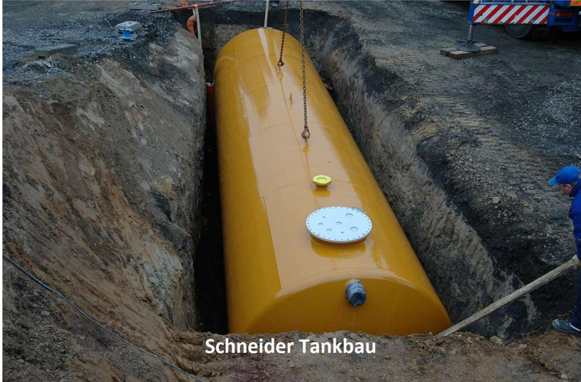
zur Lagerung von Regen- & Brauchwasser, Löschwasser, etc. Maße: D = 2,90 m - L = ca. 12,80 m
